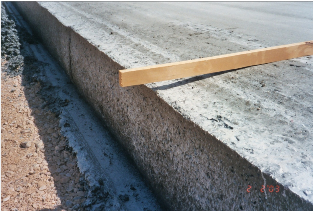
Figure 4-82 Edge Slump
